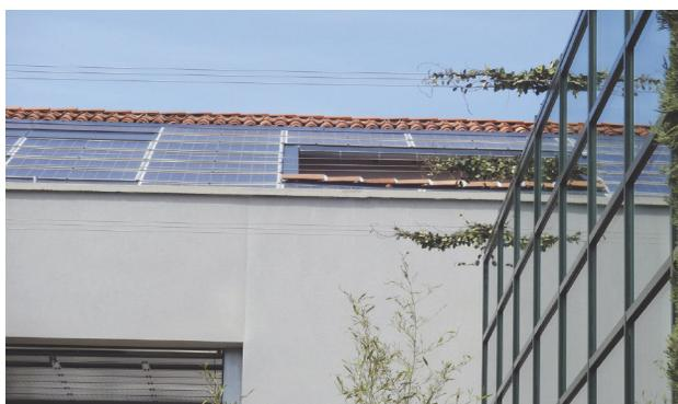
**1 800 m<sup>2</sup> de panneaux photovoltaïques** assurent l'autonomie énergétique. L'ensemble du site (locaux administratifs et unité de production) affiche un bilan carbone positif grâce à une production électrique supérieure à sa consommation.
